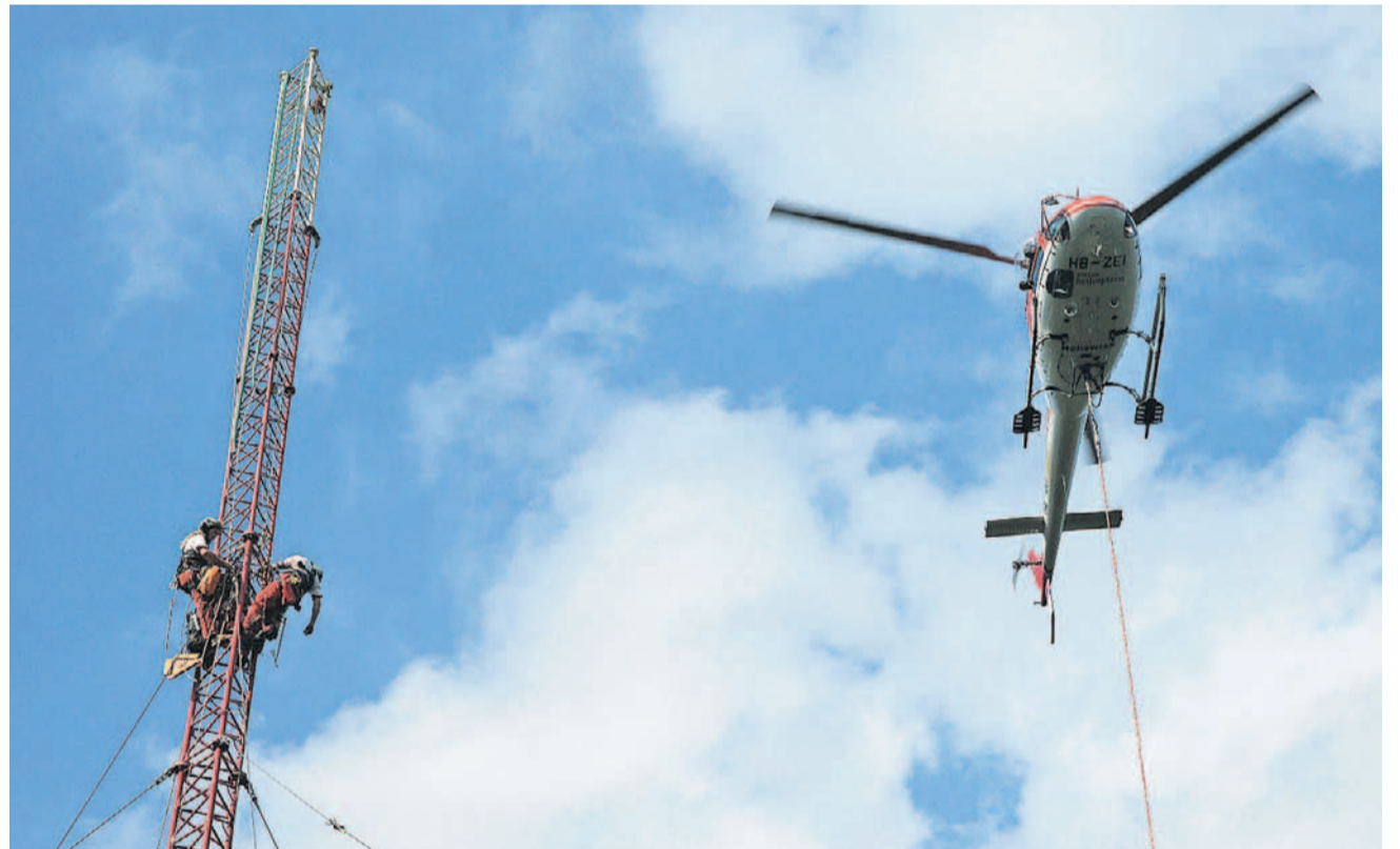
Diese Woche errichtete die EBM in Liesberg einen achtzig Meter hohen Gittermast für Windmessungen. ZVG/EBM
