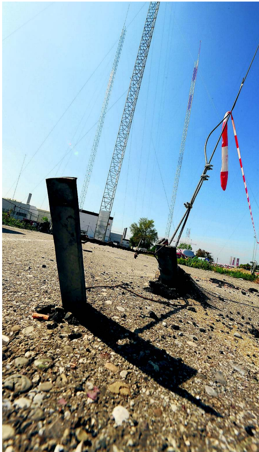
Schwindelerregende Höhen: Die Bauprofile auf dem Bus-Parkplatz sind gut gesichert. JURI JUNKOV
